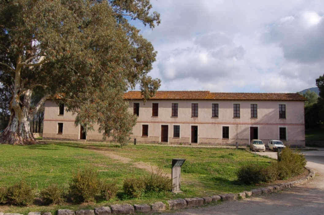
L'ex casa del Direttore della Des Forges oggi Centro Visite
